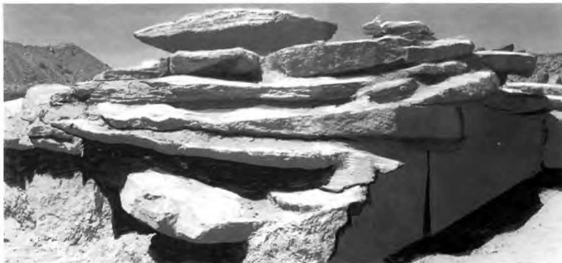
Рис. 43. Бугулы III. Пирамидально-ступенчатое перекрытие
